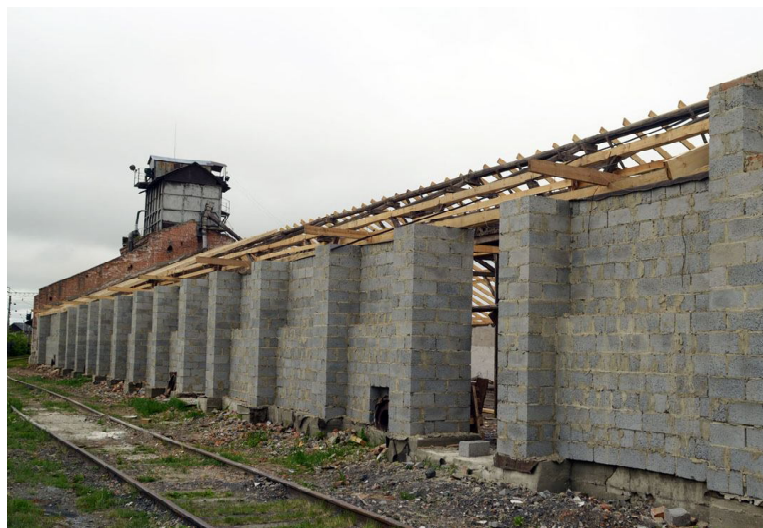
Продолжается капитальный ремонт склада
