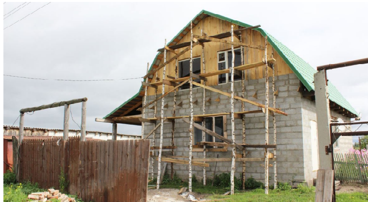
Строится новый дом
