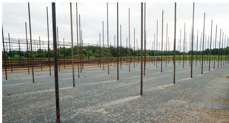
Идет строительство новых помещений для содержания животных ООО «Бизон» (с.Б-Краснояр)
